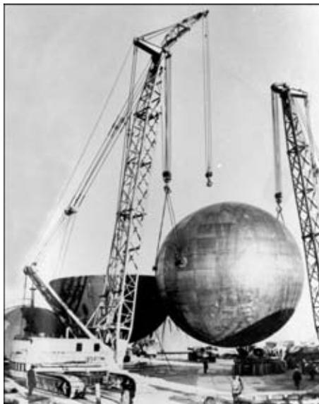
Рис. 10. Монтаж, сборка и сварка изотермического комплекта тродуговой сваркой высота подварочного шва со стороны разделки составляет 5...6 мм, усиление — 3...4 мм (рис. 9); сварка полусфер автоматом марки А-1381М с применением самозащитной порошковой проволоки в различных пространственных положениях за один проход; сборка, прихватка и сварка стоек-опор кожуха; контроль геометрии сосуда.
