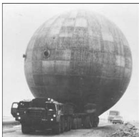
Рис. 7. Транспортировка внутренней оболочки резервуара массой 110 т к месту монтажа
