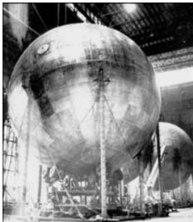
Рис. 6. Автоматическая сварка криогенного сосуда на манипуляторе
