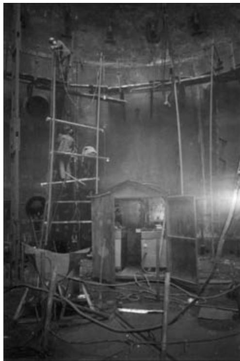
Рис. 1. Электрошлаковая сварка вертикального стыка монтажных блоков (вид с монтажной подвесной площадки, расположенной внутри кожуха домны)
