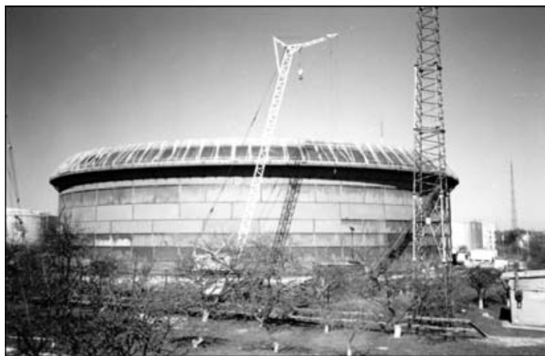
Рис. 2. Резервуар вместимостью 75000 м 3 с применением стального проката 06Г2Б класса прочности С440 г. Броды (строительство осуществлялось методом подрачивания)
