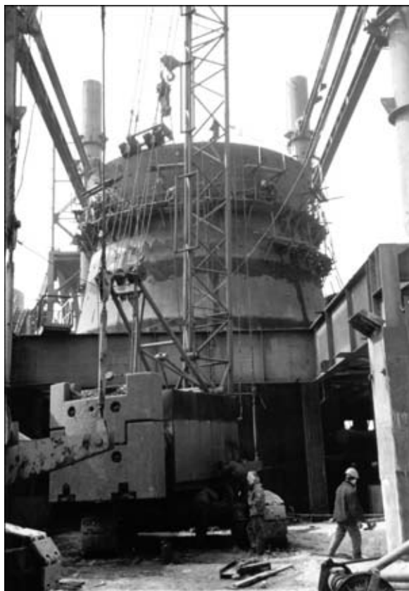
Рис. 3. Сооружение доменной печи ДП-2 на ОАО «Азовсталь»
