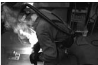
Сварка самозащитной порошковой проволокой на рабочем месте в метро (участок со сквозняками)
