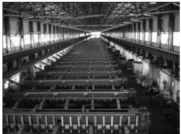
Рис. 1. Строящийся цех № 9 Иркутского алюминиевого завода
