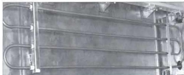
Рис. 1. Общий вид криозмеевика, смонтированного на задней стенке вакуумной камеры установки КЛ-132 (внизу справа — «холодный ввод» в вакуумную камеру)
