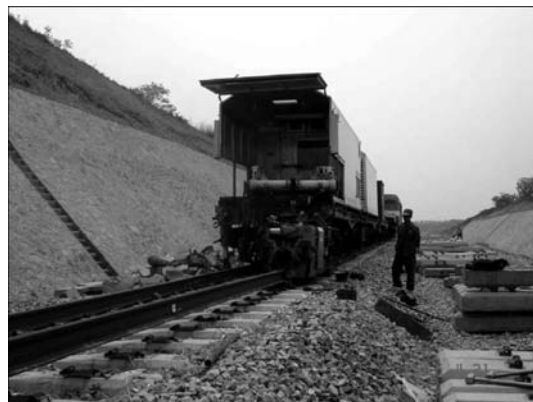
Рис. 7. Сварка рельсов передвижным комплексом К-922
