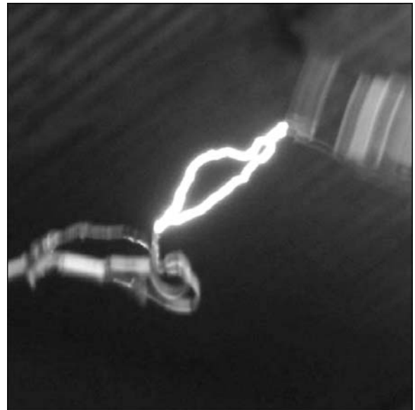
Рис. 3. Проверка функционирования системы автоматического повторного включения источника питания путем его нагружения заземленной штангой
