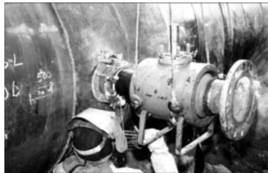
Рис. 9. Присоединение отвода Ду 150 мм к магистральному газопроводу «Союз» Ду 1400 мм, находящемуся под внутренним давлением 4,9 МПа
