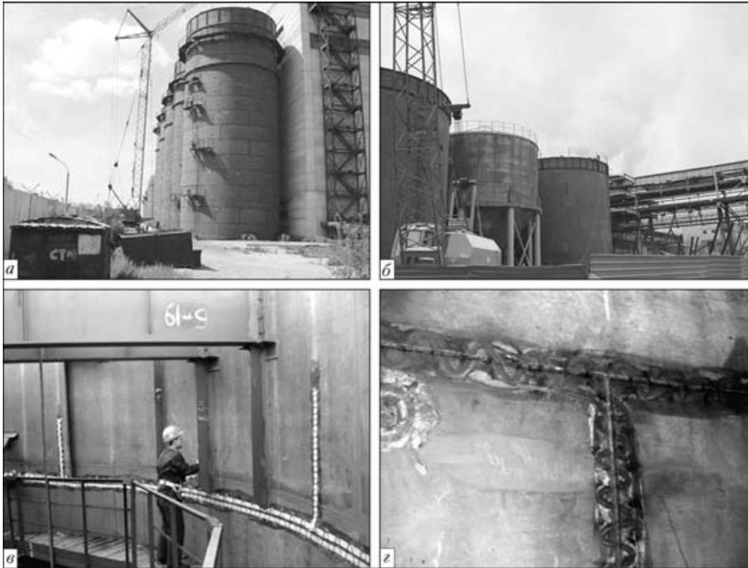
Рис. 1. Внешний вид конструкций, подвергаемых ОВз: а — батарея строящихся декомпозиоров; б — технологические баки; в — рабочий момент монтажа зарядов; г — сварные соединения после ОВз
