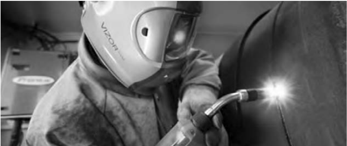
Дебют дугового процесса СМТ с переносом металла с короткими замыканиями при строительстве трубопровода
