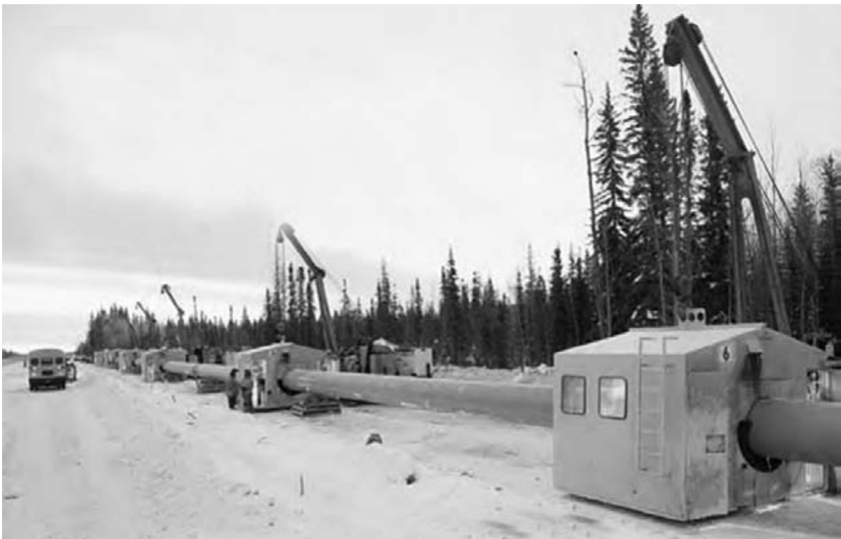
Трубопровод «Buffalo Creek West» строится в экстремальных условиях как для человека, так и для машины
