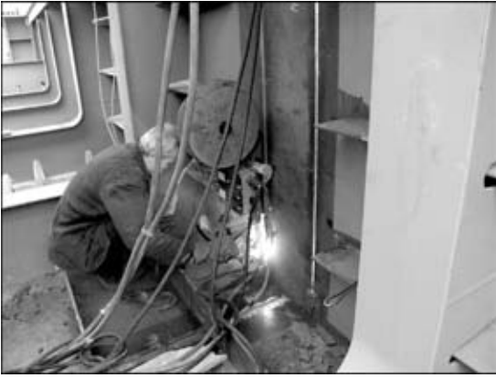
Рис. 5. Сварка порошковой проволокой ПП-АН9Н с принудительным формированием вертикальных стыковых швов пролетных конструкций Подольско-Воскресенского мостового перехода через р. Днепр в г. Киеве
