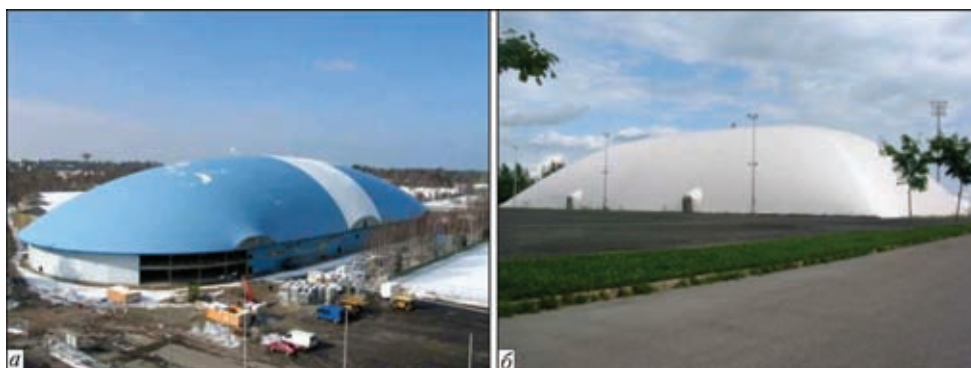
Рис. 5. Варианты конфигурации воздухоопорных конструкций компании «Вингида», Финляндия—Латвия [5]
