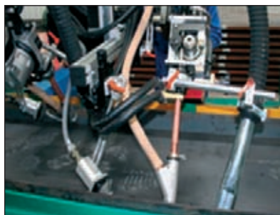
Рис. 2. Сварочная головка под слоем флюса с системой рециркуляции
