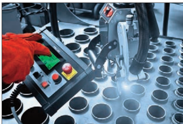
Рис. 1. Выполнение сварных соединений типа «труба-трубная доска» в нижнем положении с выступом труб с помощью углового шва
