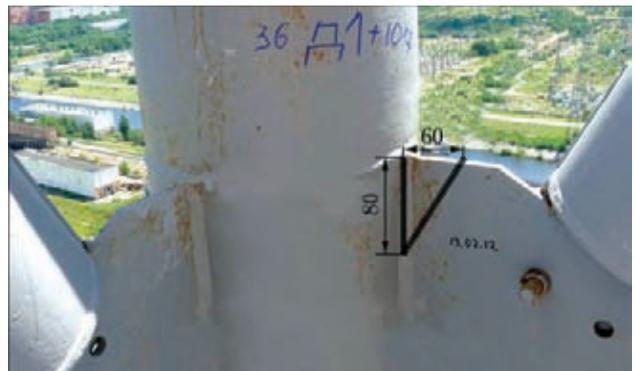
Рис. 4. Схема вырезки темплета № 2 (трещиносодержащий фрагмент фасонки с полной структурой шва до конца обнаруженной трещины)
