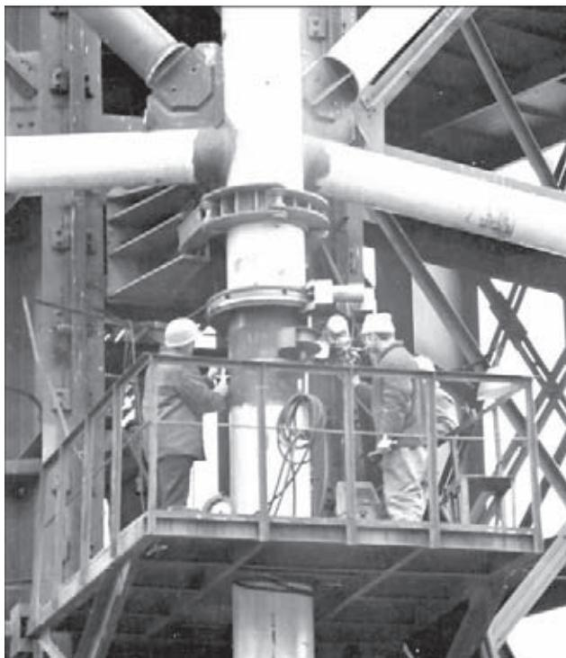
Рис. 1. Откидная монтажная площадка для выполнения автоматической сварки
