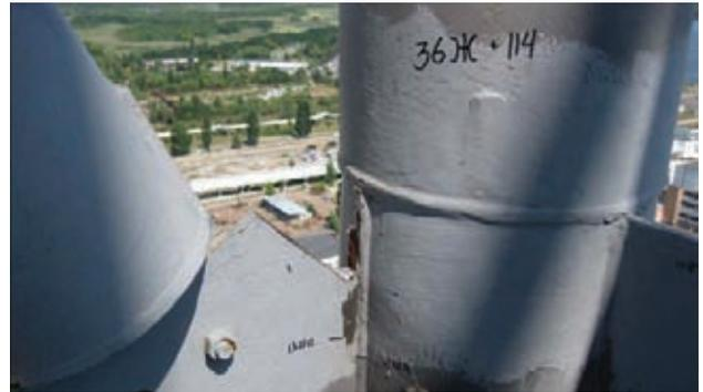
Рис. 3. Узел примыкания раскосов к стойке башни после вырезки темплета № 1
