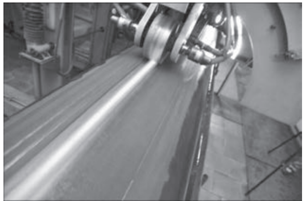
Рис. 2. Локальная термическая обработка сварного соединения трубы
