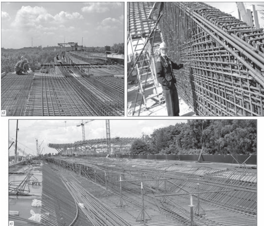
Рис. 4. Конструкции арматурных каркасов Подольского мостового перехода через р. Днепр (а), ригелей VIP-сектора НСК «Олимпийский» (б) и подъездной эстакады терминала D аэропорта «Борисполь» (в)
