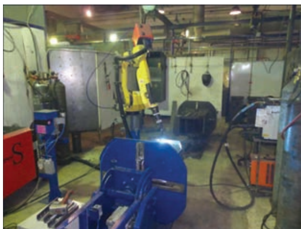
Рис. 3. Внешний вид роботизированной установки для сварки внутреннего контура котла
