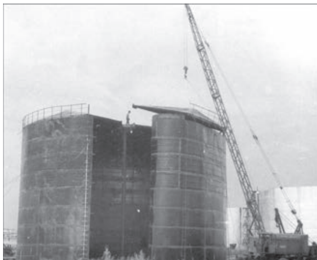
Монтаж крупногабаритного резервуара (1948 г.)
