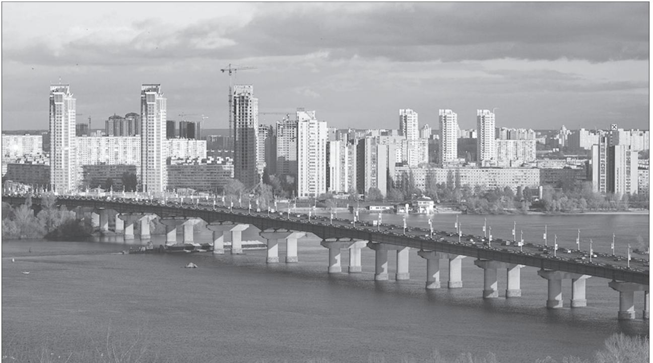
Мост им. Е.О. Патона через р. Днепр в Киеве
