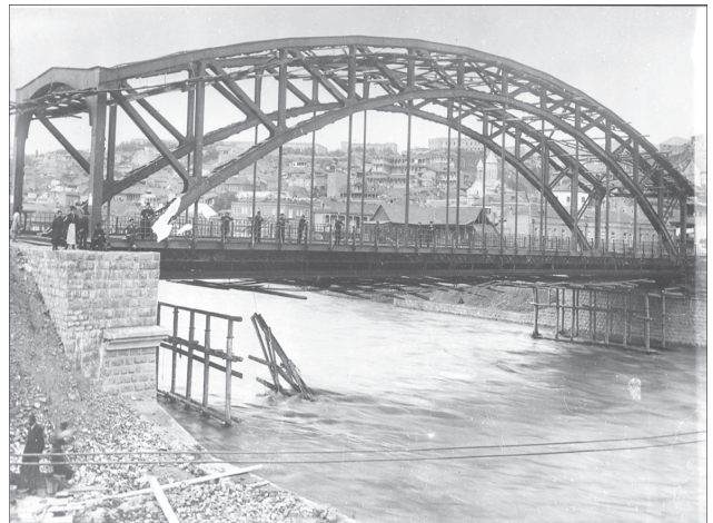
Мухранский мост через р. Куру, соединивший в 1911 г. две части Тбилиси. Е.О. Патон вместо заказанной трехпролетной конструкции выполнил мост арочным однопролетным
