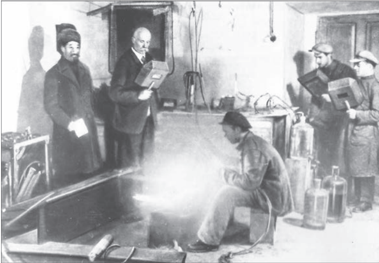
Первые эксперименты по сварке (1930 г.)
