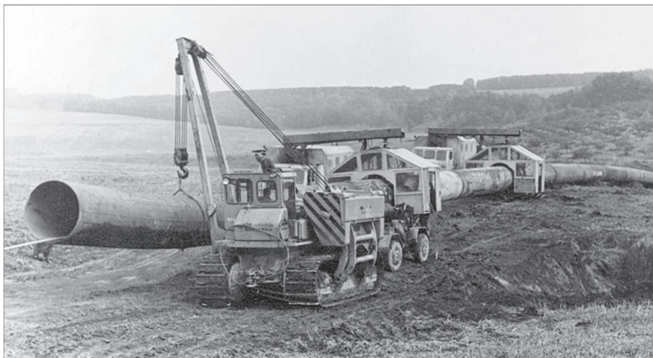
Укладка магистрального газопровода
