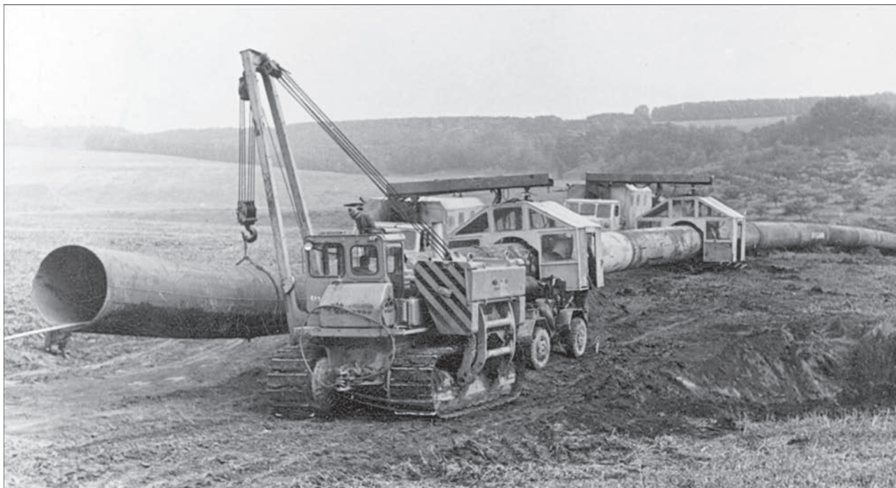
Укладка магистрального газопровода
