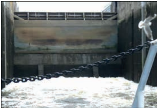
Рис. 2. Підйомно-опускні ворота Канівського судноплавного шлюзу
