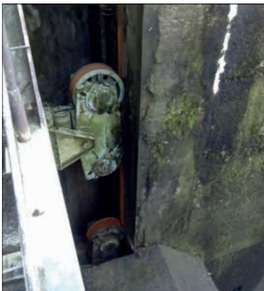
Рис. 3. Опорний візок підйомно-опускних воріт Канівського судноплавного шлюзу
