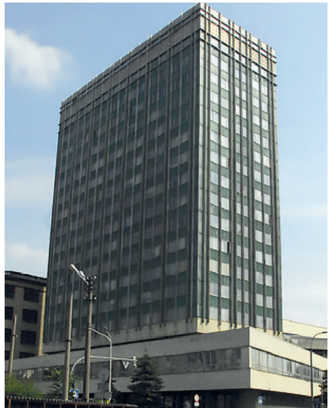
Головний корпус Інституту електрозварювання ім. Є.О. Патона
