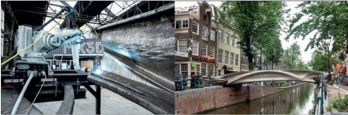
Рис. 3. Сталевий міст, створений за технологією WAAM [17]
