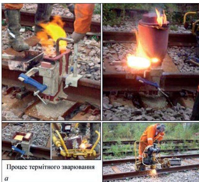
Рис. 1. Послідовність технологічних операцій при ТЗ (а) [19], макроструктура шва (б) [23]
