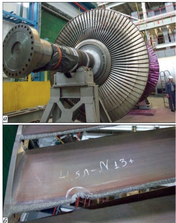
Рис. 1. Ерозійний знос робочої лопатки останнього ступеня ЦНТ парової турбіни К-1000-60/3000: а – загальний вид 5-го ступеня; б – дефект ерозійного зносу кромки лопатки
