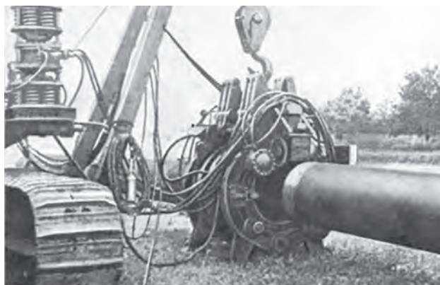
Зварювання магістрального трубопроводу за допомогою контактної трубоварювальної агрегату КТЗА-12
