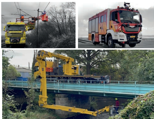
Машина на комбінованому автомобільно-залізничному ході DUOLINER MIJ призначена насамперед для проведення експертних робіт на мостових конструкціях, діагностики та детального обстеження як автомобільних, так і залізничних мостів
