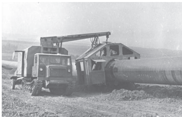
Зварювальний комплекс «Стик» на трасі «Уренгой-Помари-Ужгород»
