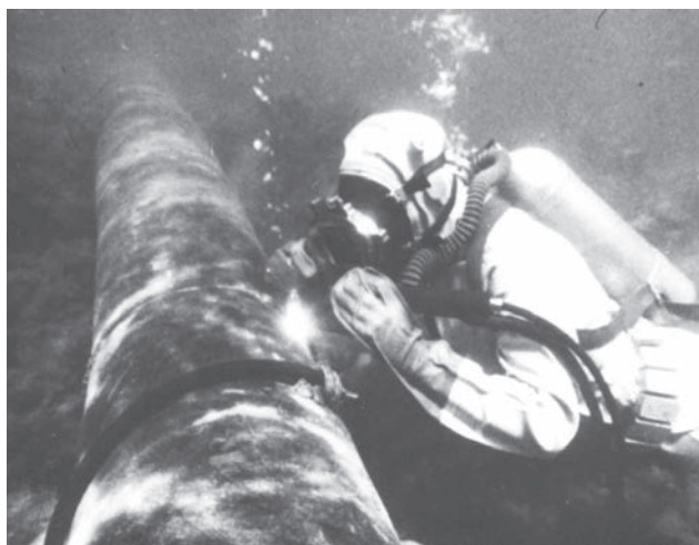
Процес зварювання порошковим дротом під водою
