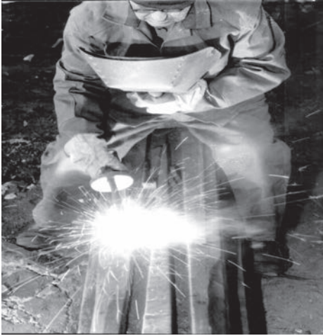
Напівавтоматичне наплавлення хрестовини стрілочних переводів порошковим дротом ПП-АН105 та наплавлена хрестовина
