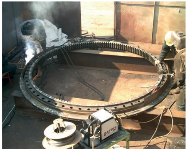
Напівавтоматичне наплавлення шестерні опорно-поворотного пристрою екскаватора
