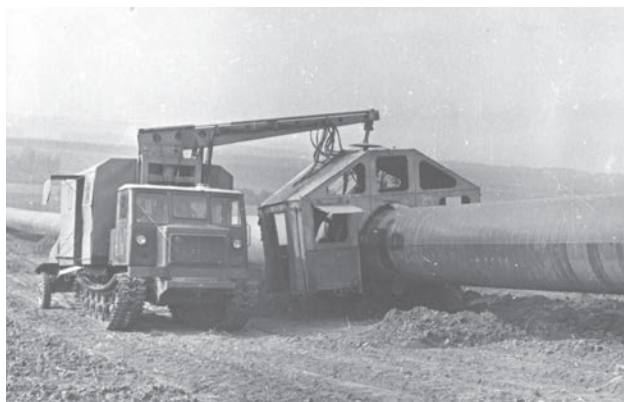
Зварювальний комплекс «Стик» на трасі «Уренгой-Помари-Ужгород»
