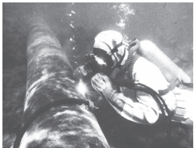
Процес зварювання порошковим дротом під водою
