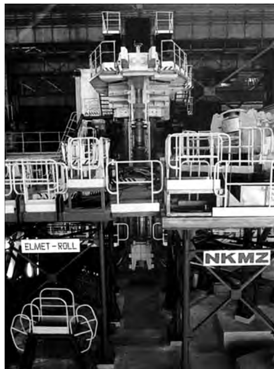
Рис. 5. Установка ЭШН ЖМ на Новокраматорском машиностроительном заводе
