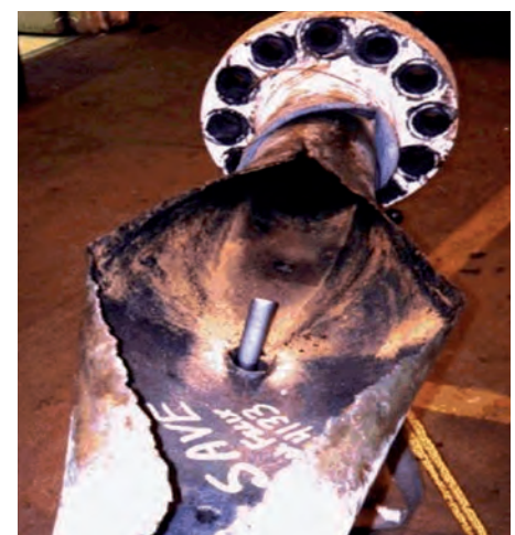
Коррозия от химката при производстве кислоты (ингибитор образования накипи). Фото любезно предоставлено Институтом Энергии, Лондон
