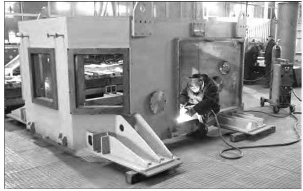
Рис. 6. Сварка камеры плавки печи ВТ02
