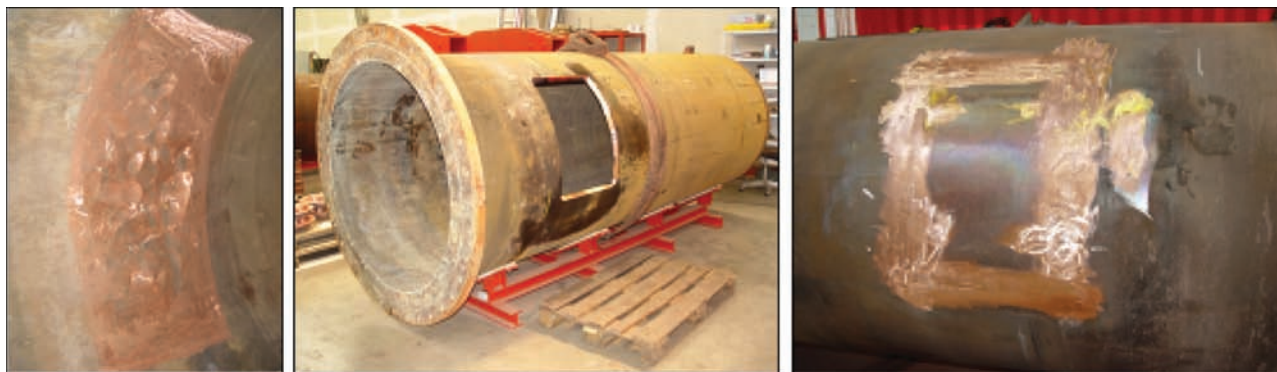
Рис. 17. Ремонт кокилей путем замены дефектных участков
