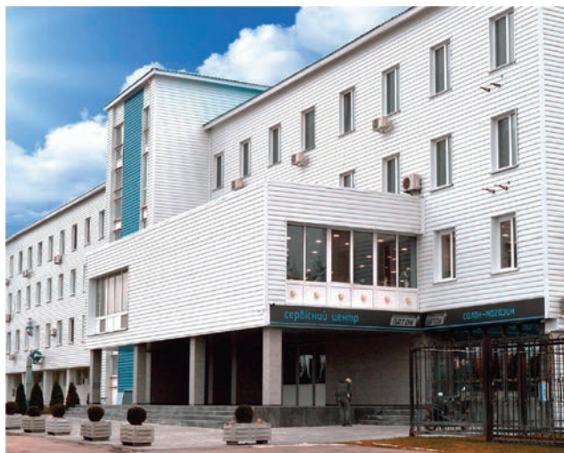
Центральний корпус ДЗЗУ ім. Є.О. Патона
