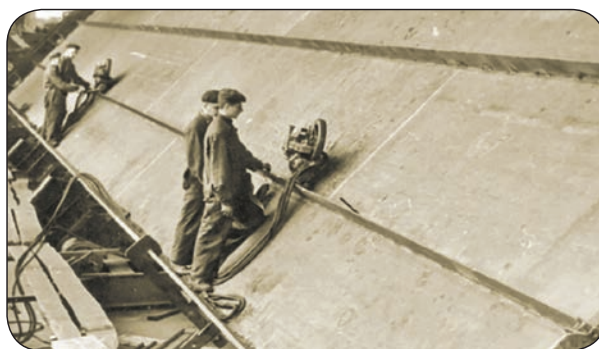
Зварювання балки мостового перекриття, м. Дніпропетровськ (1952 р.)
