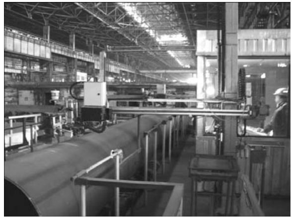
Рис. 2. Система автоматизированного УЗ контроля продольных сварных швов труб в технологической линии ТЭСЦ № 2 ОАО «ХТЗ»
