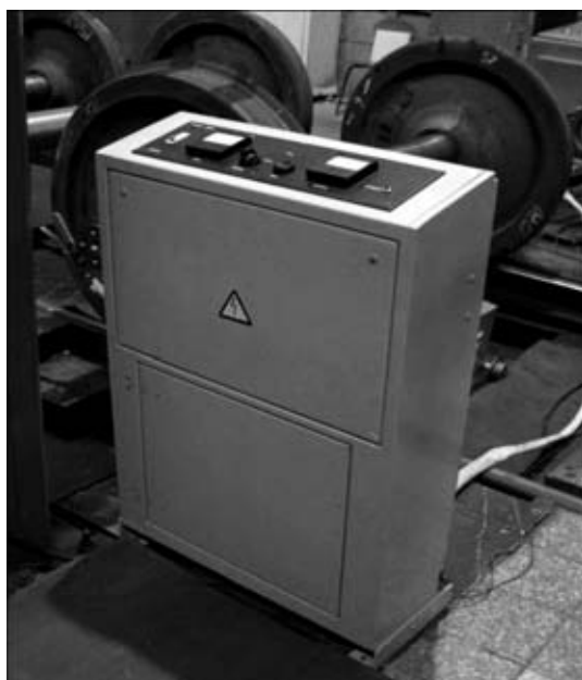
Рис. 7. Общий вид модернизированного блока управления
