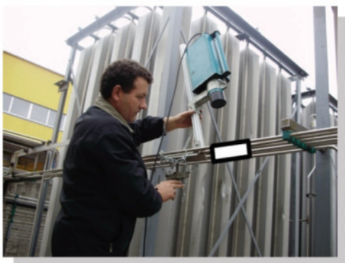
Установка аппаратуры на объекте
