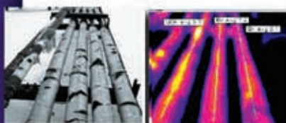
Видимое и тепловое изображение магистрального трубопровода
