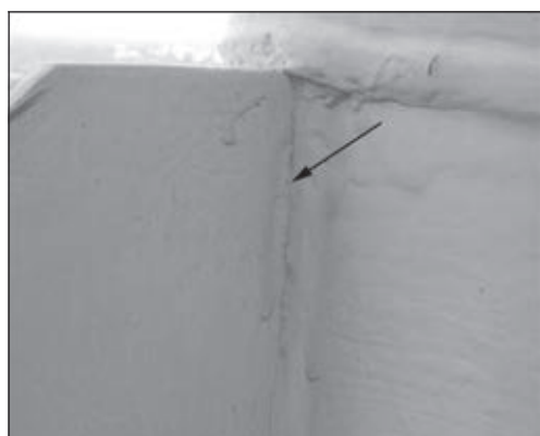
Рис. 4. Характерное повреждение по границе перехода от шва к основному металлу прорезной фасонки
