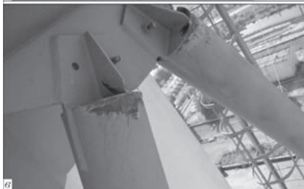
Рис. 6. Трещина в заглушке в зоне ребра левого (а) и правого (б) раскоса длиной около 150 мм по линии (37-Д1)-(37-Ж) ниже отметки +107,72 и общий вид расположения раскосов под площадкой ниже отметки +107,72 в зоне крепления к горизонтальной связи по линии (37-Д1)-(37-Ж) (в)
