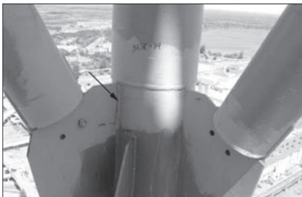
Рис. 2. Узел примыкания раскосов к опорной стойке \varnothing 325 \times 8 мм в узле 36-Ж на отметке 114,92 м с обнаруженным ранее дефектом (показано стрелкой)
