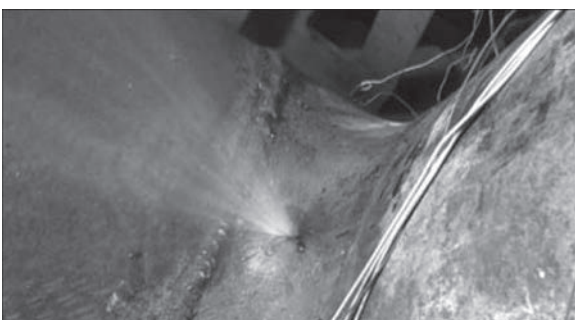
Рис. 4. Разрушение натурального образца в зоне II
