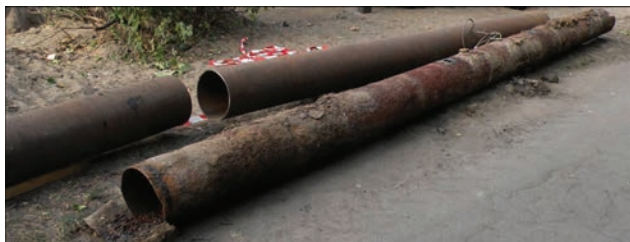
Рис. 10. Демонтированный участок трубопровода
