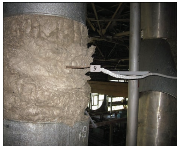
Рис. 5. Восстановление теплоизоляции после установки волновода с датчиком акустической эмиссии
