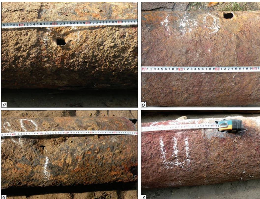
Рис. 14. Дефектные участки трубопровода на расстоянии 90 см (а), 195 (б), 5,8 м (в) и сварной шов на расстоянии 256 см (г)
