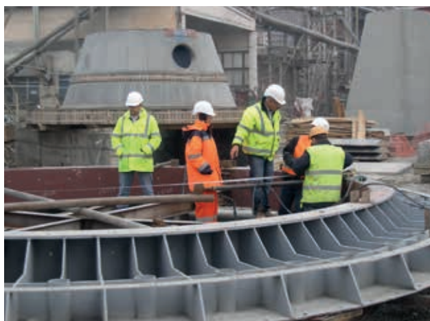
Проведення діагностики зварних з'єднань на Подільському цементному заводі
