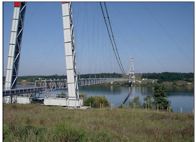
Рис. 9. Кілометрова ділянка магістрального аміакороводу Тольятті–Одеса на мосту через р. Дніпро
