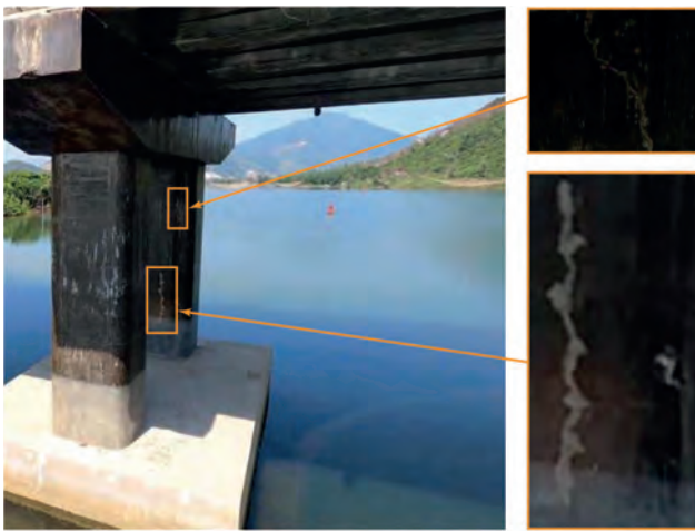
Figure 6. A snapshot from a recorded video taken by the robot. Two zoomed-in areas on the right side show the crack location Рис. 6. Знімок із записаного відео, який зроблено роботом. Дві збільшені області праворуч показують розташування тріщини
