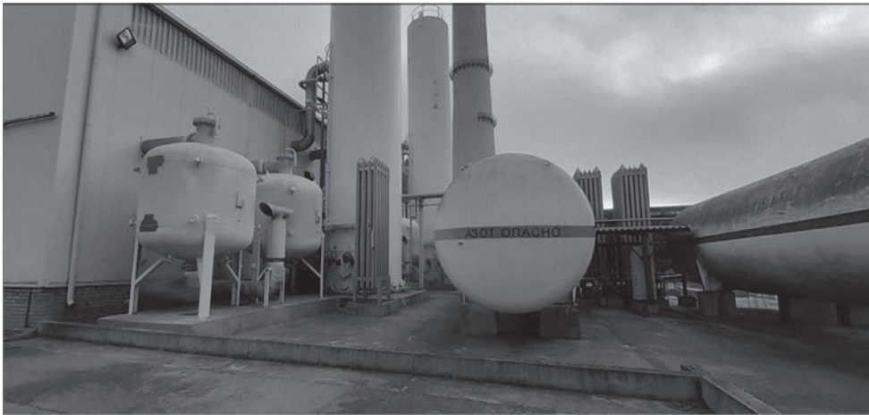
Рис. 1. Посудини, що працюють під тиском, на станції розподілу повітря
