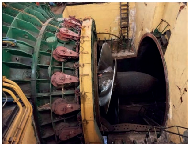
Рис. 1. Зовнішній вигляд капсульного агрегата ГА-6
