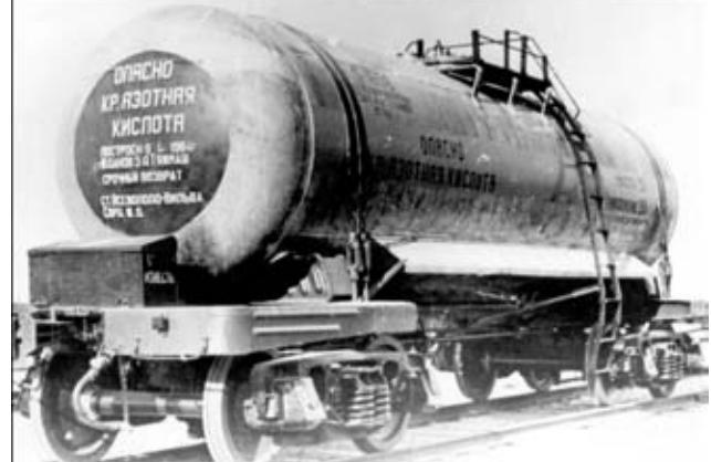
Рис. 4. Железнодорожная цистерна для перевозки химических агрессивных продуктов
