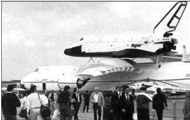
Рис. 1. Орбитальный самолет «Буран»
