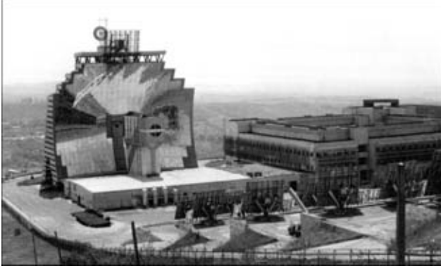
Рис. 9. Бизеркальная оптико-энергетическая установка — солнечная печь мощностью 1 МВт Института материаловедения НПО «Физика — Солнце» (пос. Паркент, Ташкентская обл.)
